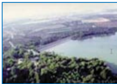
Barrage de Rezirk
