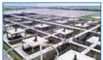
Station d'épuration de Béja pour protéger l'oued Mejerda
